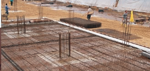
Couche de propreté fiable sous les radiers.
